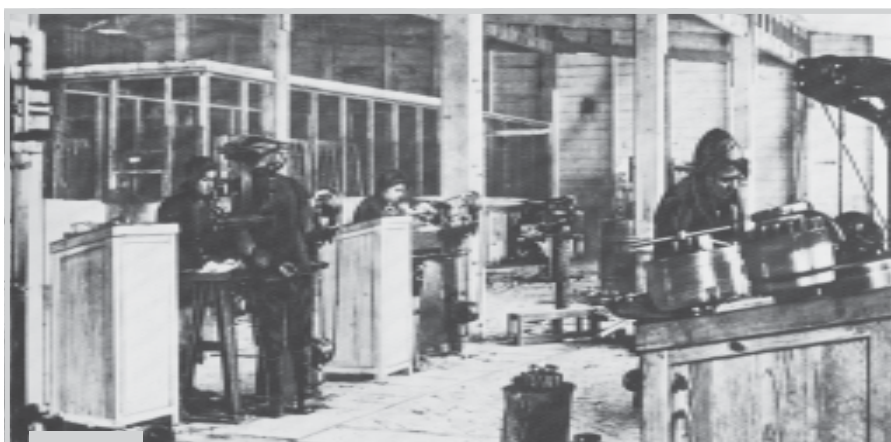
Устанавливается эвакуированное оборудование
