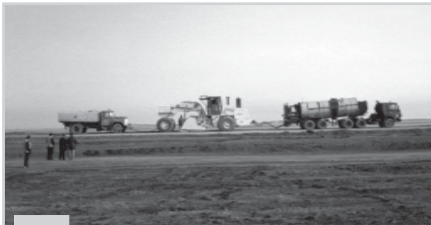
Стабилизация грунта на автодороге Журавка — Ново-Красное в Чистоозерном районе, с применением ресайклера «БОМАГ-МРН.122»
