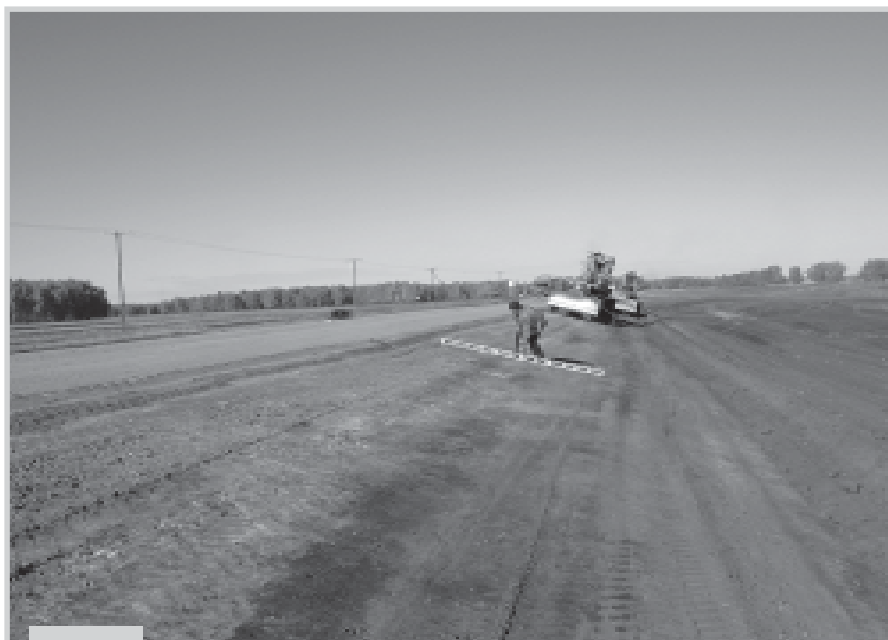
Возведение земляного полотна при строительстве новой автодороги. Планировка откосов земполотна
