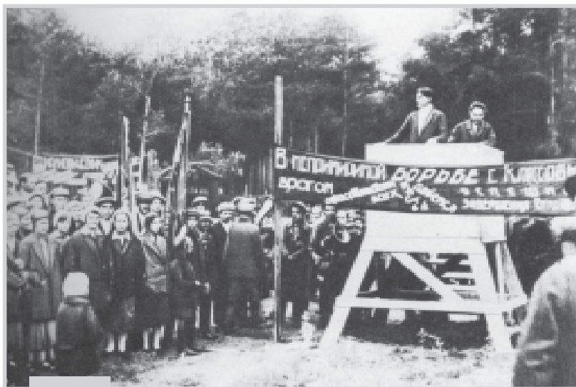
Митинг, посвященный началу строительства обувной фабрики
