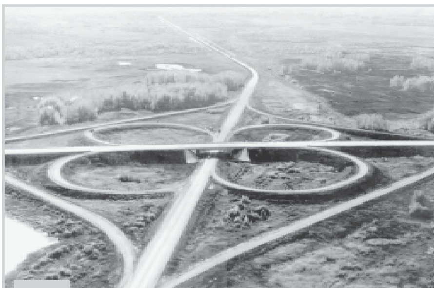
Автомобильная развязка на трассе Омск—Новосибирск
