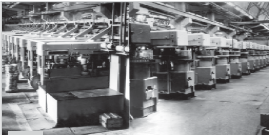
Комплексно-механизированный участок монтажа изделий «СТ»
