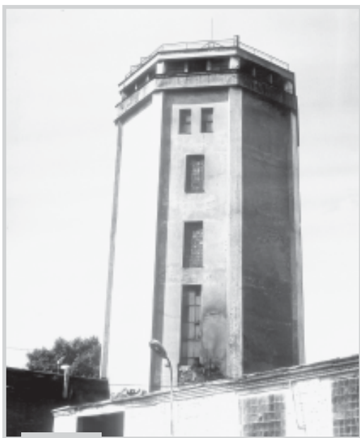
Водонапорная башня на улице Добролюбова
