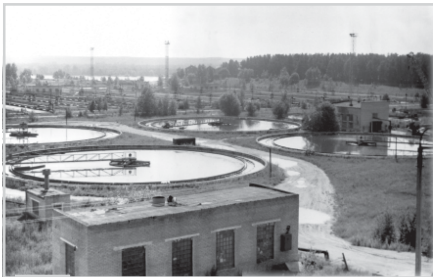
Очистные сооружения канализации
