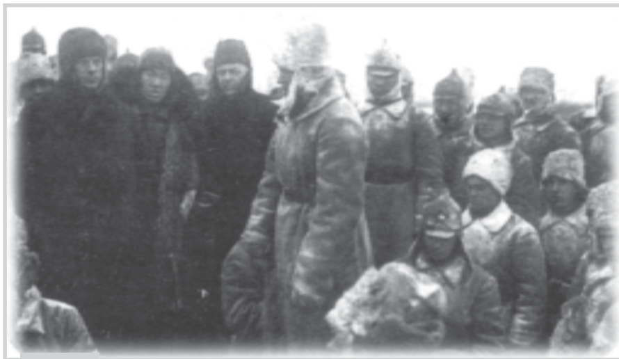
Курсанты полковой школы на расчистке территории будущего завода
