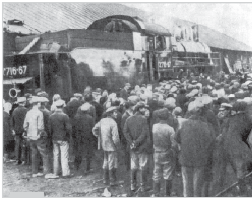
По железнодорожной ветке на стройку пришел первый паровоз
