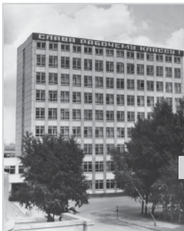
Здание заводоуправления завода низковольтной аппаратуры
