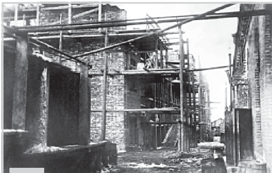
Строительство мыловаренного завода в 1924 г.
