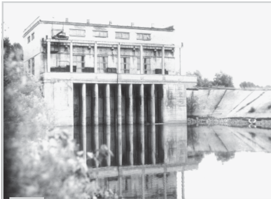
Водозабор с насосной станцией первого подъема (НФС-5)
