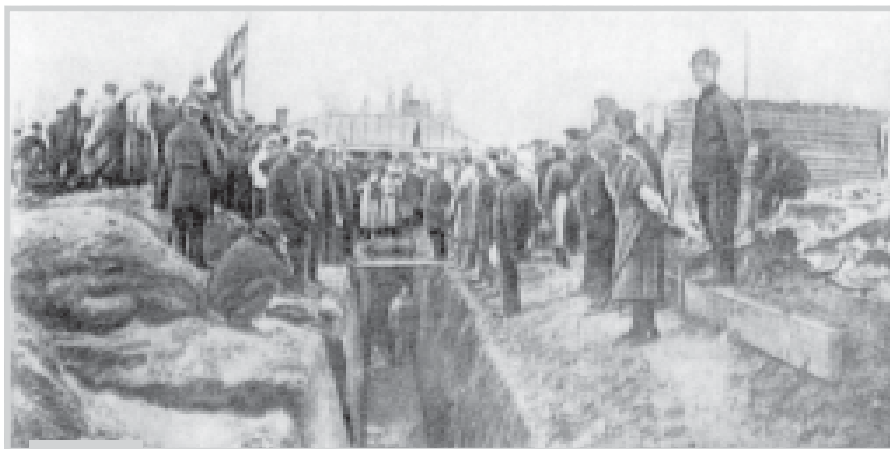
Торжественно проходила закладка гидрозавода
