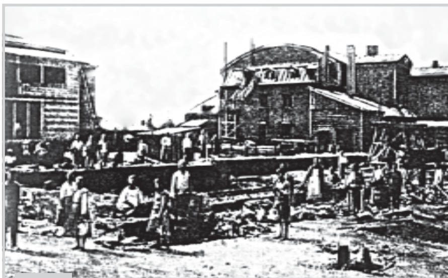
Строители — вчерашние крестьяне — возводят здание парокотельного и машинного отделений
