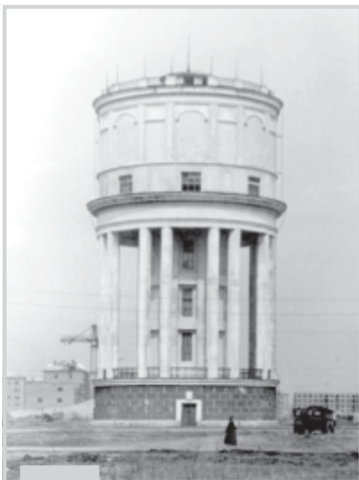
Знаменитая башня, давшая название целому жилому району
