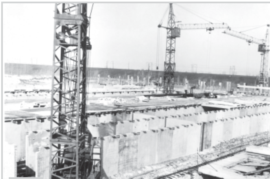
Строительство горизонтальных отстойников
