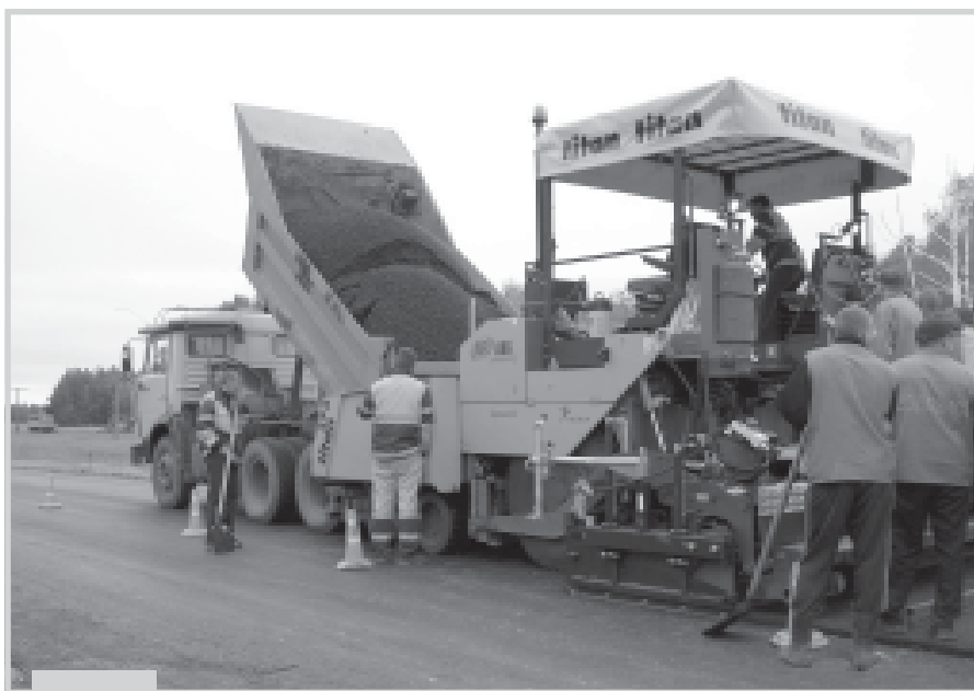
Ремонт автодороги Новосибирск — Ордынское — Карасук на участке Кочковского района. Укладка асфальтобетонной смеси асфальтоукладчиком «ТИТАН» (Германия)
